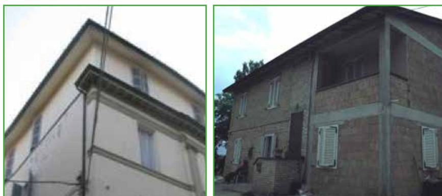
Figura 18. Esempio di ampliamento (sinistra) e piano sopraelevato (destra).
