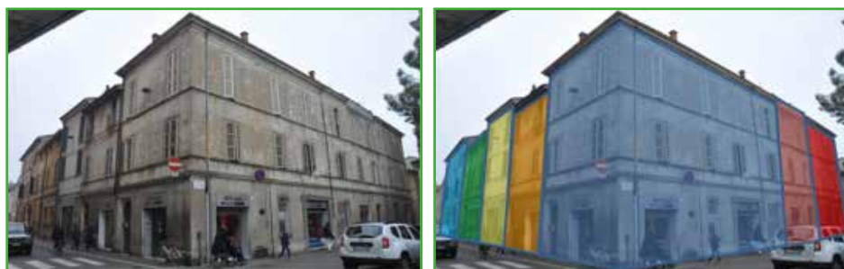
Figura 1. Immagini di un aggregato strutturale tipo (sinistra) e sua articolazione in unità strutturali (destra, Centro storico di Faenza).
